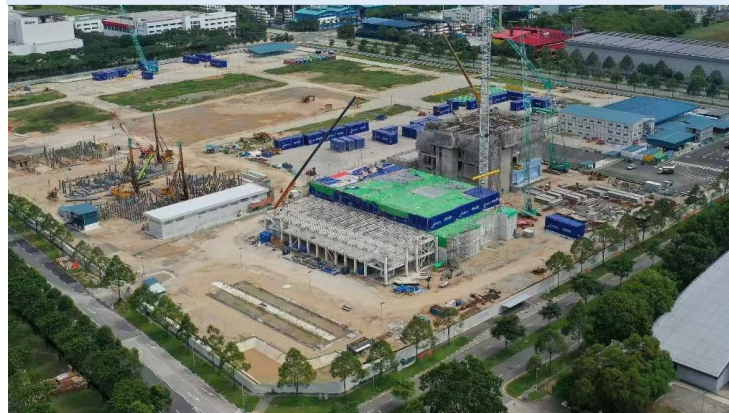
施工建设中 – 2024年12月
